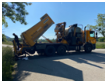
Enduit bicouche en émulsion de bitume gravillonnée sur le plateau des Daines et sur les voiries communales. Coût 19 K€ TTC
