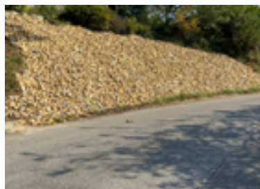
Réfection du talus route de Moisy suite à un affaissement important. Coût 18,8 K€ TTC
