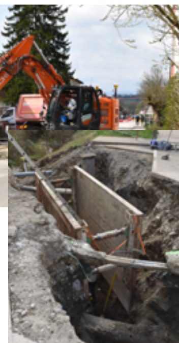
Réalisation d'un réseau d'eaux pluviales Route du Tram - Diamètre 500mm sur 100 ml de longueur à plus de 3 ml de profondeur. Coût 109 K€ TTC
