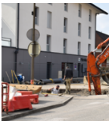
Réalisation d'un réseau d'eaux pluviales Route du Tram - Diamètre 500mm sur 100 ml de longueur à plus de 3 ml de profondeur. Coût 109 K€ TTC
