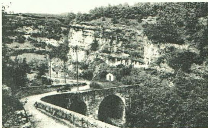
Le pont des Douattes avant les travaux de l'arche du tramway
