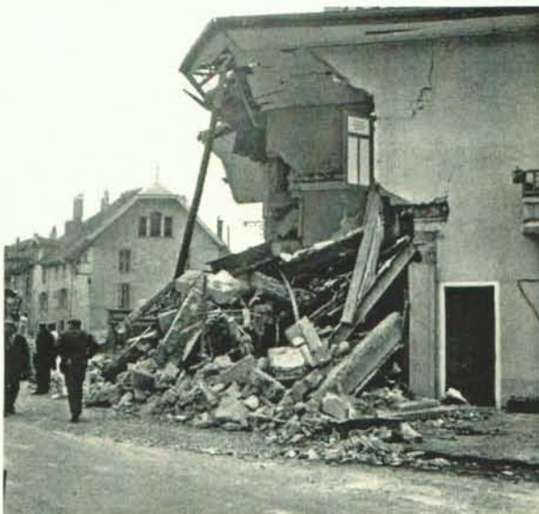
Un poteau improvisé soutient la charpente menaçante. A droite, la porte d'entrée Keller
