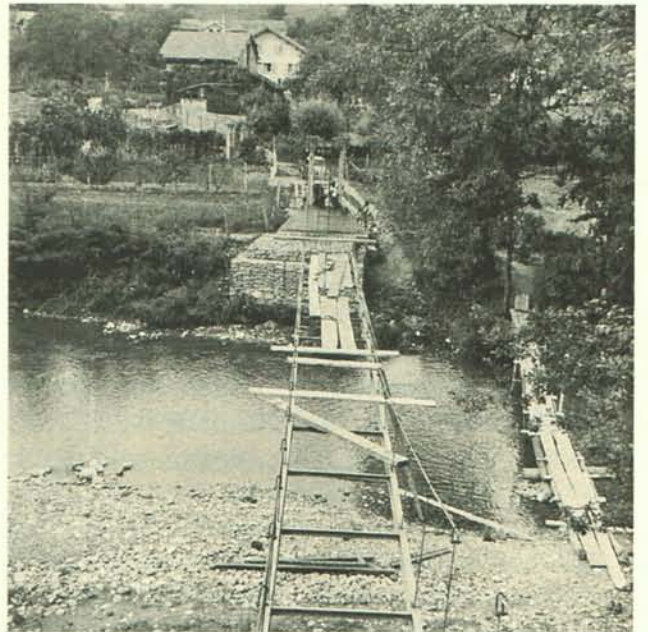
Les travaux de la nouvelle passerelle de Brameloup en 1962, réalisés par Louis Crochet.
