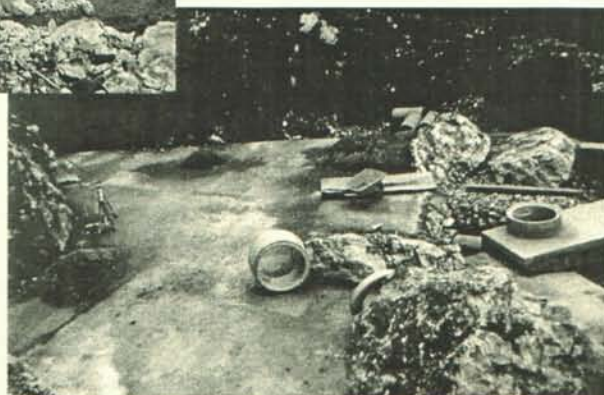
Captage avant la couverture en béton.
