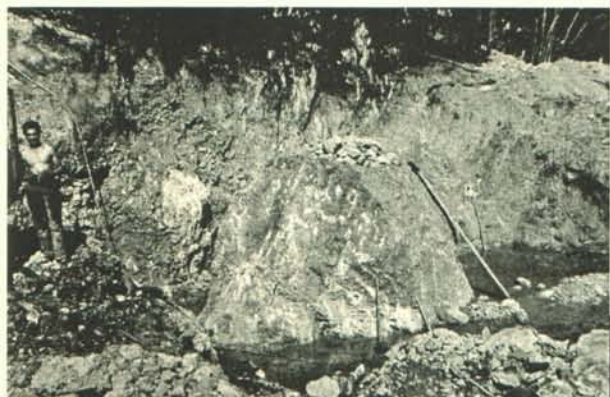
Captage avant la couverture en béton.
