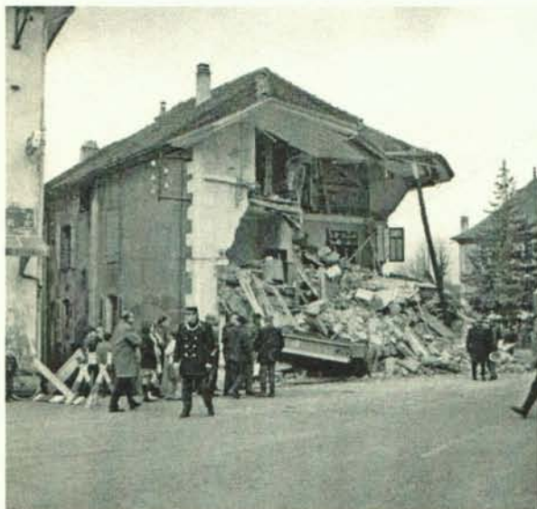
La crémérie Keller à droite et la librairie de Mme Cornillon à gauche ont été complètement détruites
