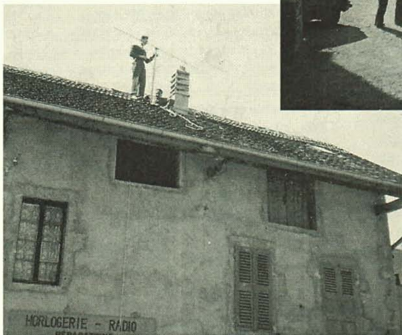
Voilà! La première antenne est installée au-dessus du magasin
