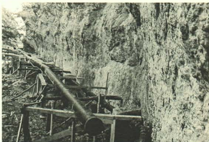
1965 - Mise en place de la nouvelle colonne à côté de celle de 1924.
