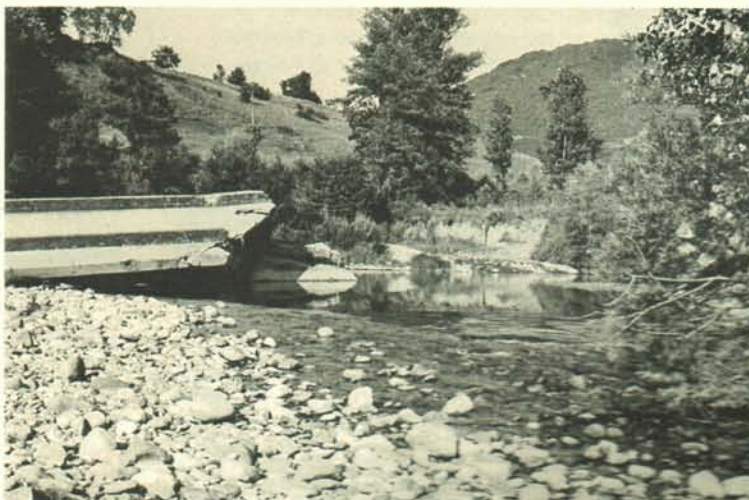
Le pont du Tram écroulé, situé sur le Fornant, près du confluent. Le projet du tram fut délaissé en 1927.
